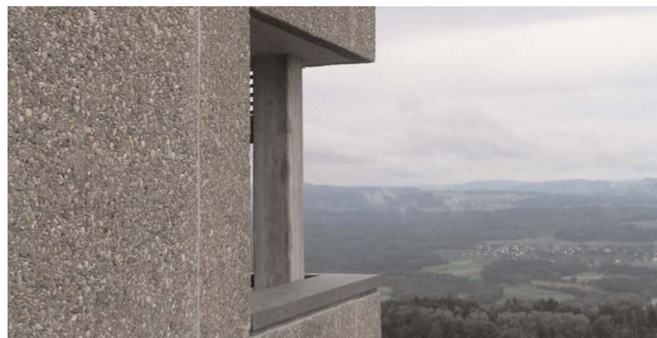
Talseite: Gebäudedeck vor und nach dem Schnitt
