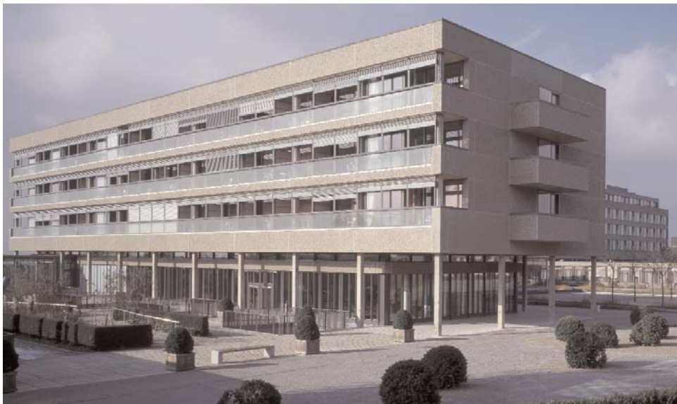
Neue Plastizität des Baukörpers
