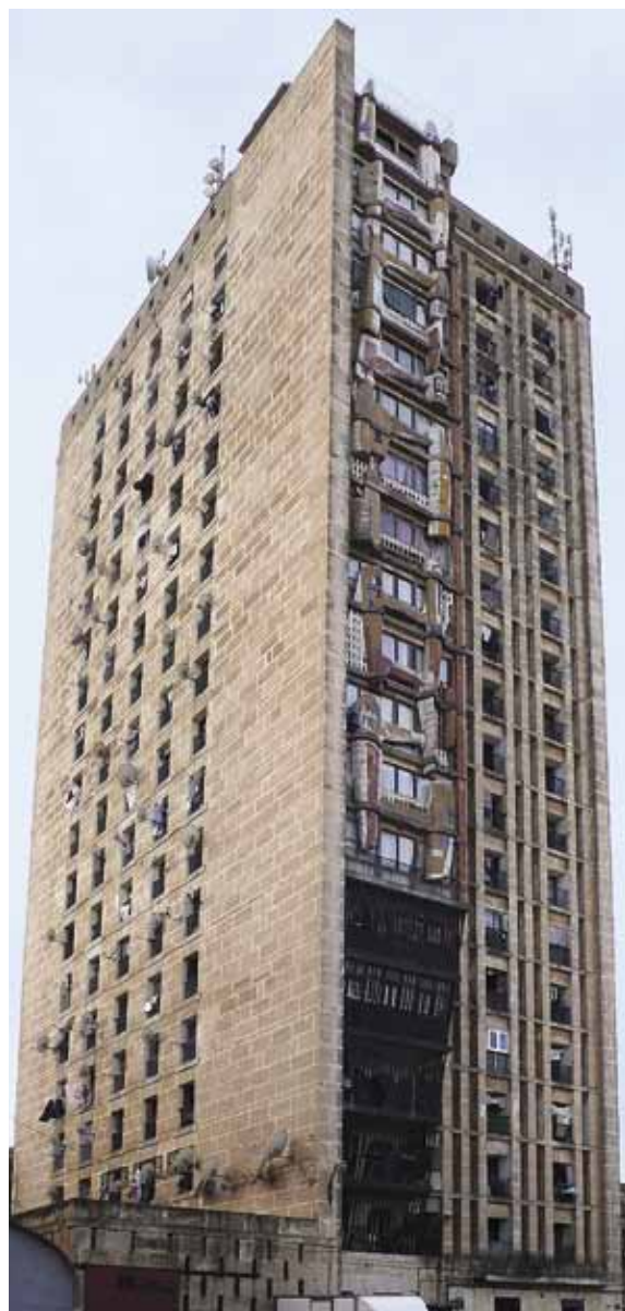
Diar-Es-Saada, Wohnturm in Algier: Die Lebendigkeit der Fassade entsteht durch plastischen und tektonischen Einsatz von farblich nuancierten Natursteinen. Architekt Fernand Pouillon. Foto Aita Flury
