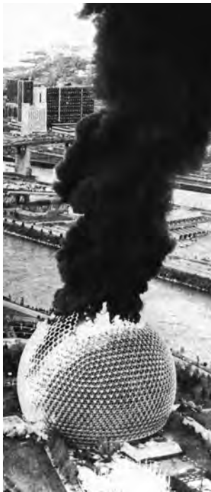
Abb. 31: Brand an der Expo '67 in Montreal: Die Acrylpaneele schmolzen in nur 15 Minuten. R. Buckminster Fuller (1895–1983) in Zusammenarbeit mit unbekanntem Architekten: US-Pavillon, Montreal (CA) 1967
