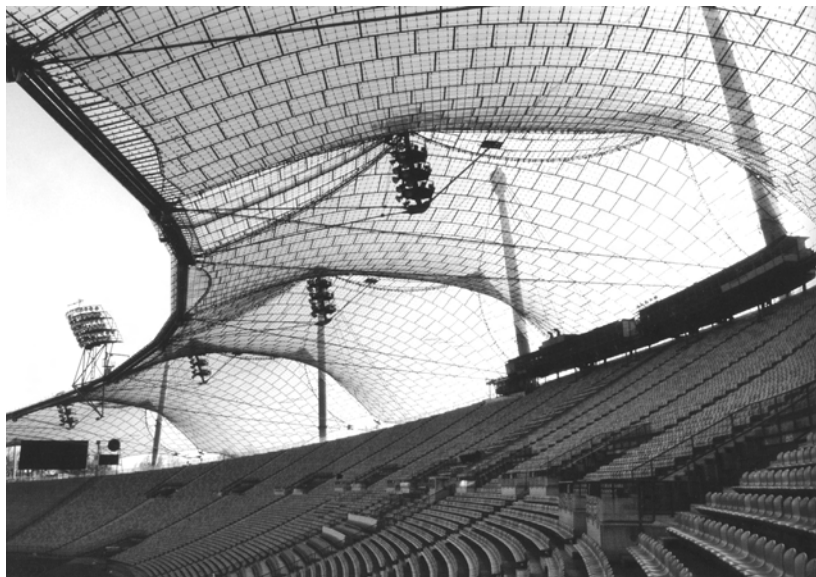
Abb. 47: Zeltkonstruktion mit Acrylglashaut
