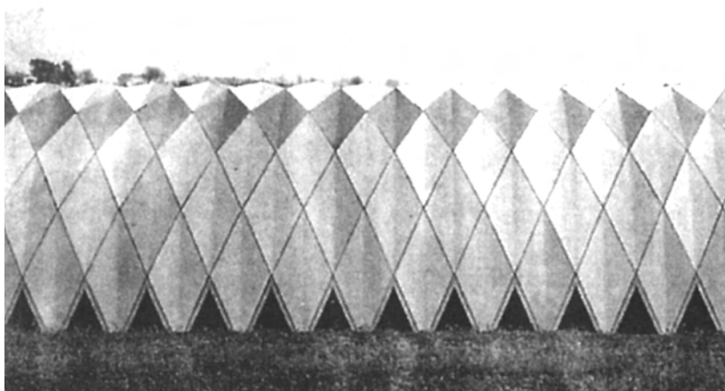
Abb. 38: Falwerk aus glasfaserverstärktem Kunststoff: einer der ersten Bauten von Renzo Piano Renzo Piano: Salzlagerhalle, Pomezia bei Rom (I) 1966
