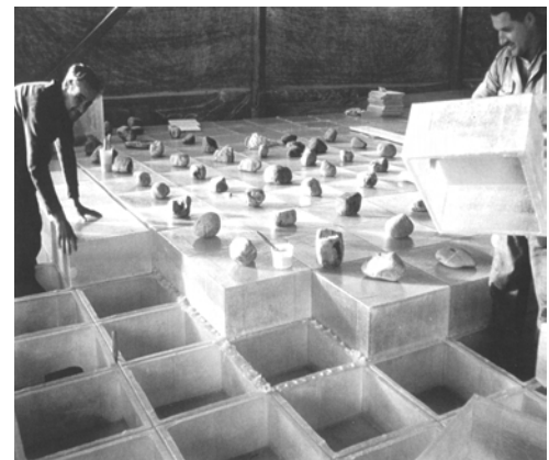
Abb. 39: Handarbeit trotz innovativem Material Heinz Isler: Tankstellendach, Thun (CH) 1962
