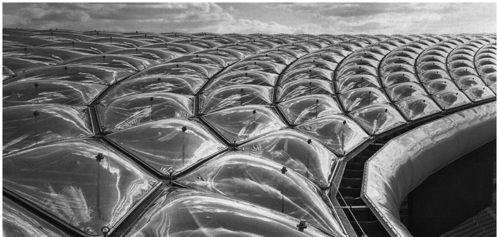
Abb. 52: Luftkissen aus Kunststoffmembranen auf dem Stadiondach Herzog & de Meuron Architekten: Allianz Arena, München (D) 2002
