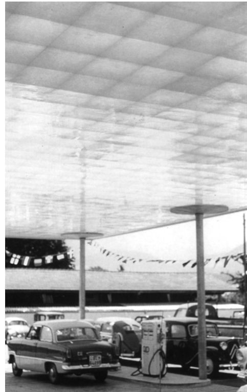
Abb. 42: Leichtigkeit durch Transluzenz Heinz Isler: Tankstellendach, Thun (CH) 1962
