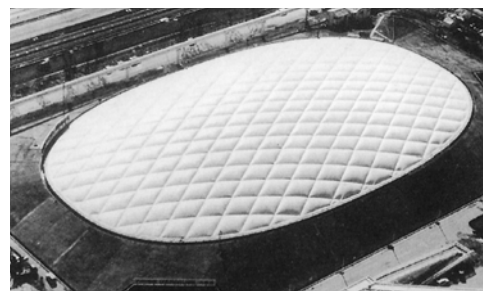
Abb. 49: Membranstruktur für eine stützenfreie Halle
