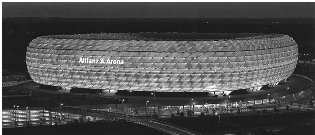
Abb. 51: Pralle Membrankissen bilden die transluzente Hülle des Fussballstadions. Herzog & de Meuron Architekten: Allianz Arena, München (D) 2002
